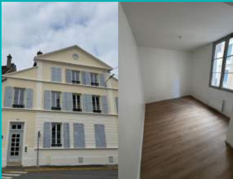
Réception des travaux de réhabilitation des immeubles 32 rue Bancel et 9 rue des Cloches à Melun
