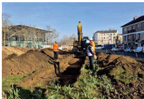
Du côté du tribunal, c'est tout le stationnement qui a été refait, avec la découverte de poteries anciennes. SPL Melun Val de Seine
