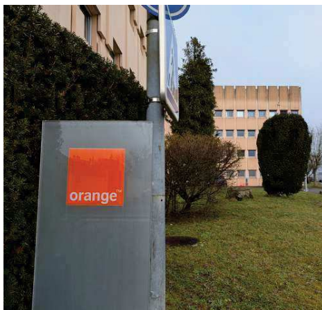
Situé dans le nord de Melun, le centre névralgique de la transition entre l'ADSL et la fibre est tenu par Orange W.L/RSM77
