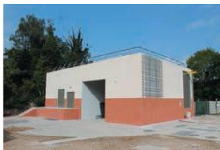
Le PR4, situé en bords de Seine, près du chemin de halage, est le dernier maillon avant la station d'épuration de Dammarie-lès-Lys et c'est par lui que transitent 85% des effluents traités par cette station, ce qui représente 3000m<sup>3</sup> d'eaux usées et pluviales par heure, au maximum, soit l'équivalent de 6 piscines municipales !
