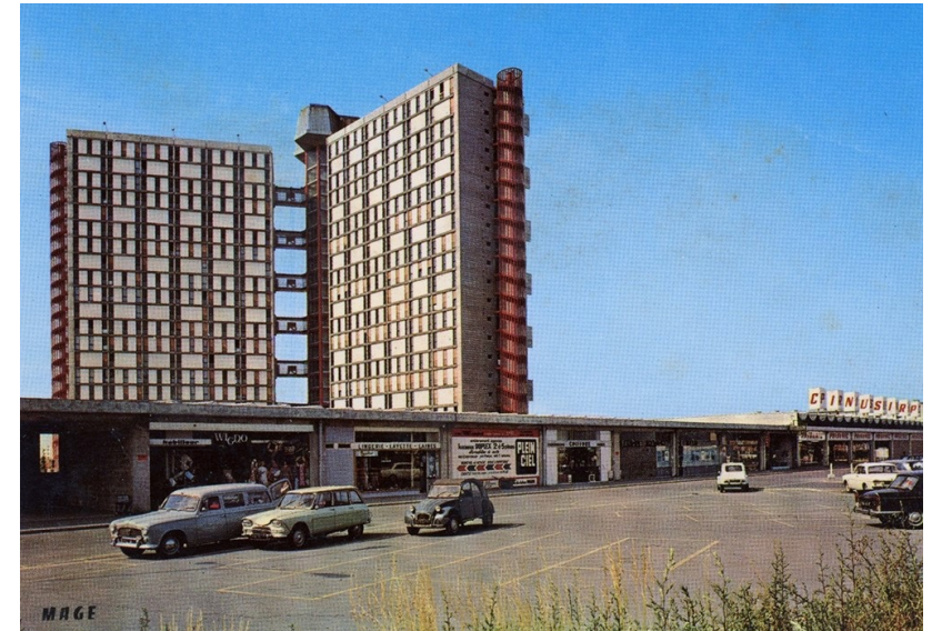
Plein Ciel en 1968, vue des ailes A et B.
